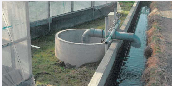
写真1：集水槽に表面水などを集め水中ポンプで排水
